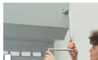
NHK - Notbedienung mittels Nothandkurbel
