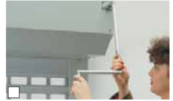
NHK - Notbedienung mittels Nothandkurbel
